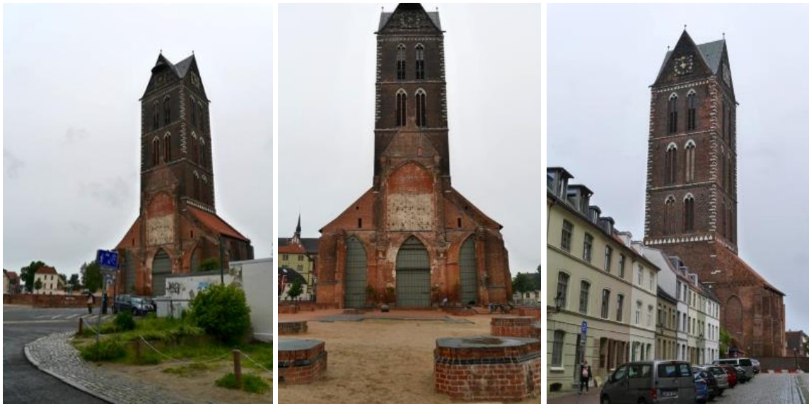
Abb. 2: Ansicht von Osten mit neuen Grundmauern. Abb. 3: Ansicht von Nordosten Abb. 4: Forum St. Marien in Wismar. Ansicht von Westen.
