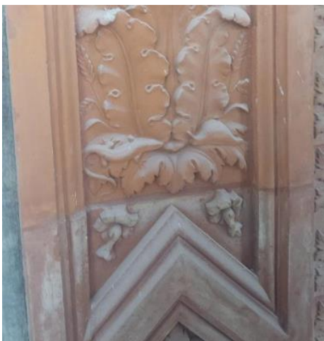
Abb. 6: Teil der Terrakottafassade; vor bzw. nach der Salzreduktion.
