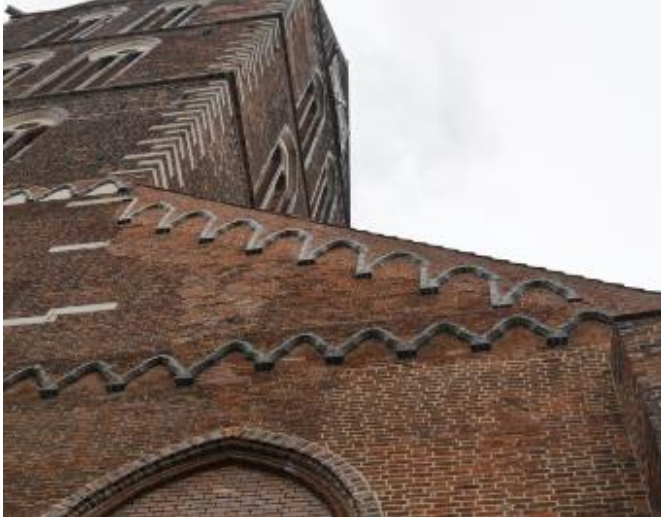
Abb. 4: Seitenschiff mit Versackung
