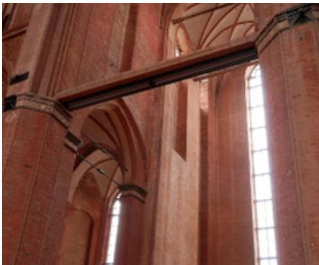
Abb. 3: Eingesetzte Balken mit hinabfahrbaren Leinwänden zur Verbesserung der Akustik.
