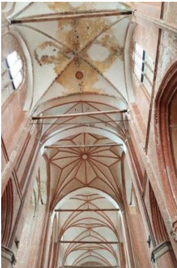
Abb. 2: Eingebaute Balken an restauriertem Deckengewölbe.
