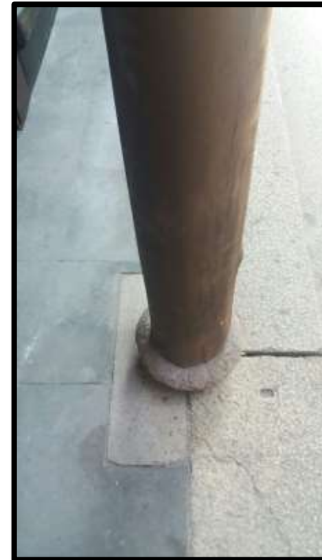
Beispiel einer tragenden Stütze
