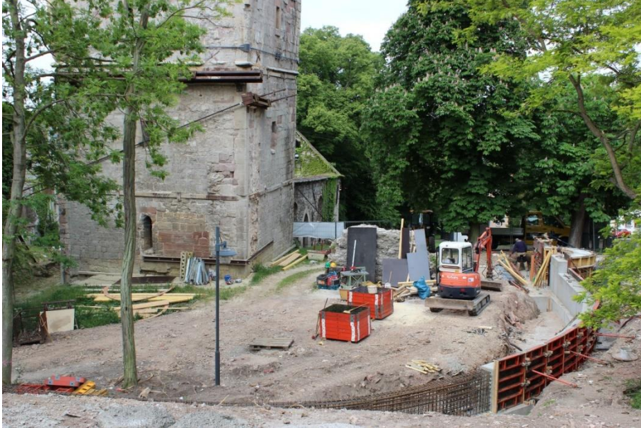
Abb. 15: Gekrümmte Stützwand (r.) sowie Verankerungen und Spannbänder am Turm (Foto: R. Hartmann, 2015)
