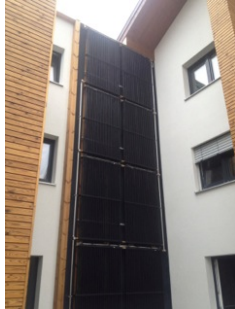
Fassadenmontage SLK-W
