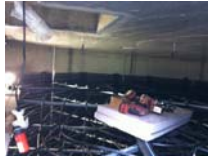
Kameramontage im Eisspeicher
