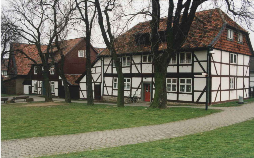
Bild 1 Gebäude Weinberg 6 und 7
