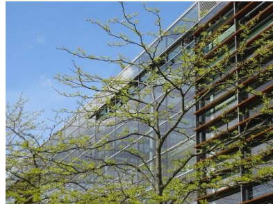
BBS International headquarters Hanover - Germany BBS中心 汉诺威 - 德国
