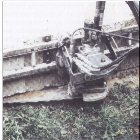
Abb. 4.13: Mauer sägemaßnahmen, links: manuell, rechts: fahrbar [Frössel (2001), S. 128 ff.]
