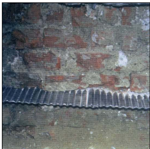
Abb. 4.14: Chromstahlblech im Mauerwerk [Frössel (2001), S. 132]
