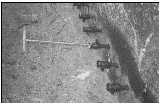
Abb. 4.20: Durchstoßen der mineralischen Vorinjektion [Kabrede (2003), S. 83]
