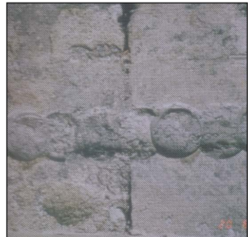
Abb. 4.15: links: Ausbohren einer Bohrlochreihe, rechts: Verschluss mit Dichtmörtel [Frössel (2001), S. 127]
