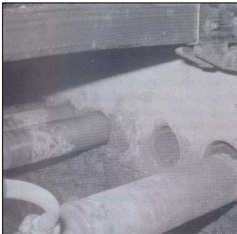
Abb. 4.15: links: Ausbohren einer Bohrlochreihe, rechts: Verschluss mit Dichtmörtel [Frössel (2001), S. 127]
