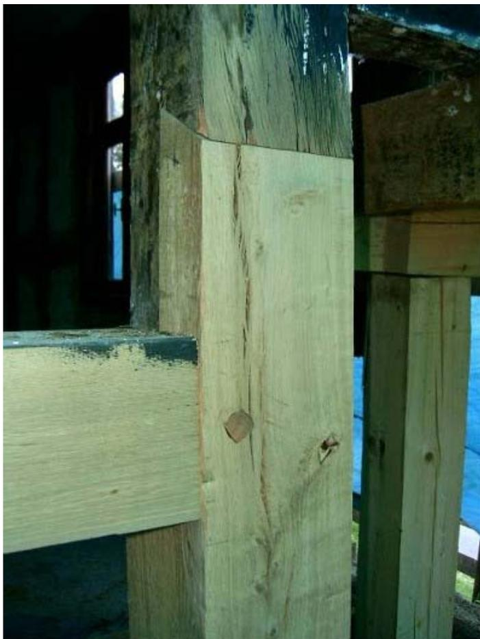
gebunden wurden. Erst Blätter, Zapfen und Kämme, sowie Holznagelverbindungen ermöglichten die Fachwerkbauweise. Durch die wandernden Handwerksgehlen wurden diese Techniken in ganz Europa verbreitet. Die Fachwerkbauweise kennt keine Metallteile, somit entfallen diese auch bei der Instandsetzung. Sind in früheren Restaurierungsabschnitten Stahl- oder Eisenteile eingebaut worden, ist zu prüfen, ob sie durch Holz ersetzt werden können. Besonders Metallteile, die durch die Außenhülle dringen, verur-
