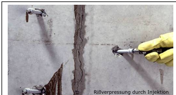
Abb.4 Bohrpacker während der Verfüllung [16]
