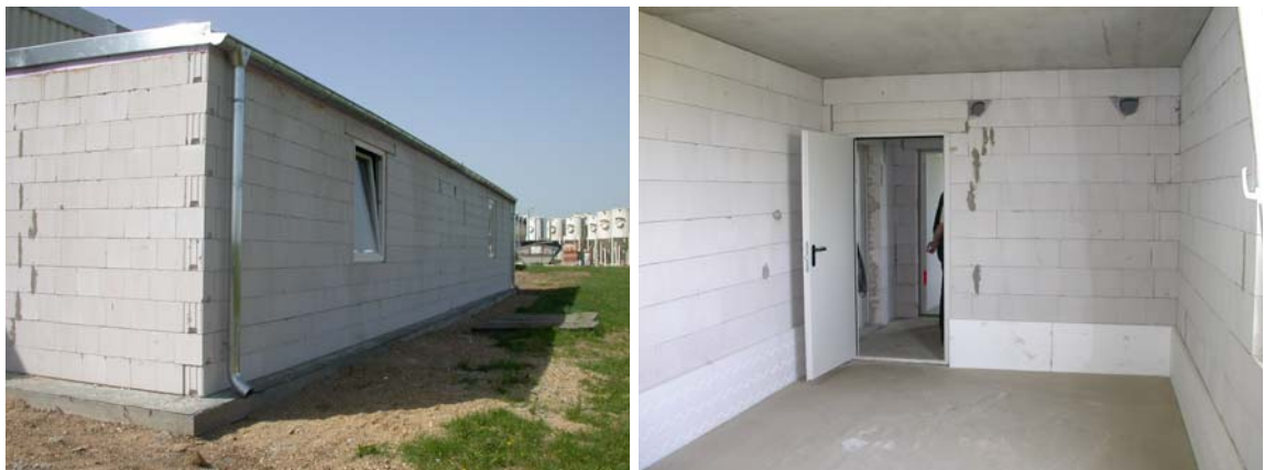
Abb. 1 + 2: Ansicht des Gebäudes mit den Prüfräumen von Süd-Osten und Blick in den im Rohbau befindlichen Prüfraum B.
