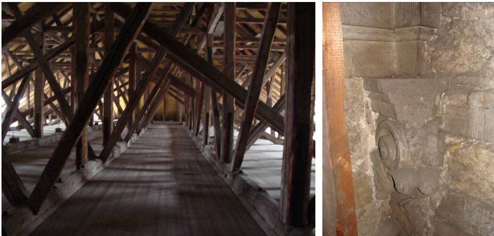
Abb. 14 und 15 St. Trinitatis, Dach
